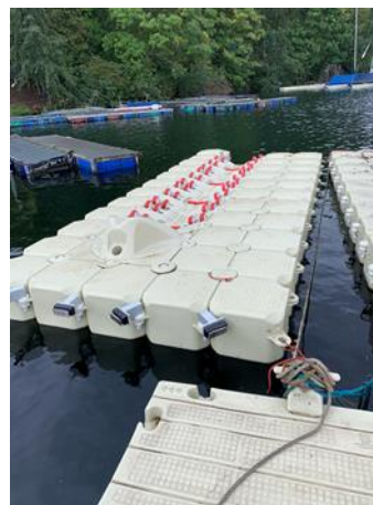
Erfolgte Montage der Produkte Boatlift und Sunny Dock
